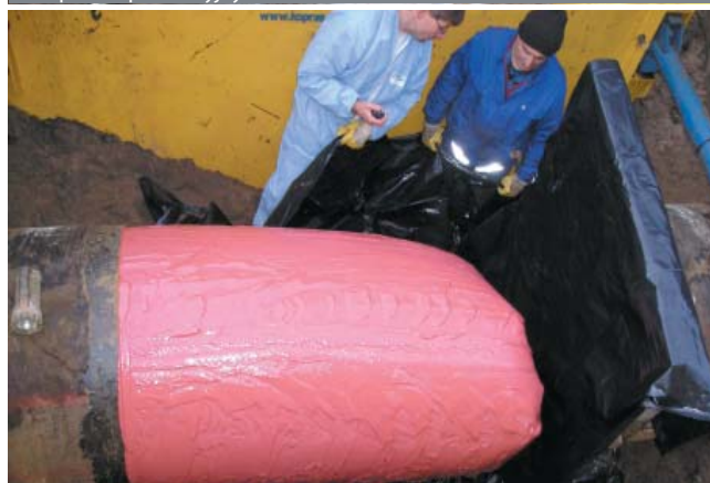
Fot. 4. Wprowadzanie rękawa do wykopu końcowego
