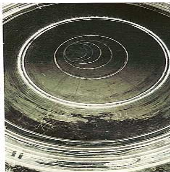
Wyłożenie częściowe ze systemem AMEX-10 VARIO
