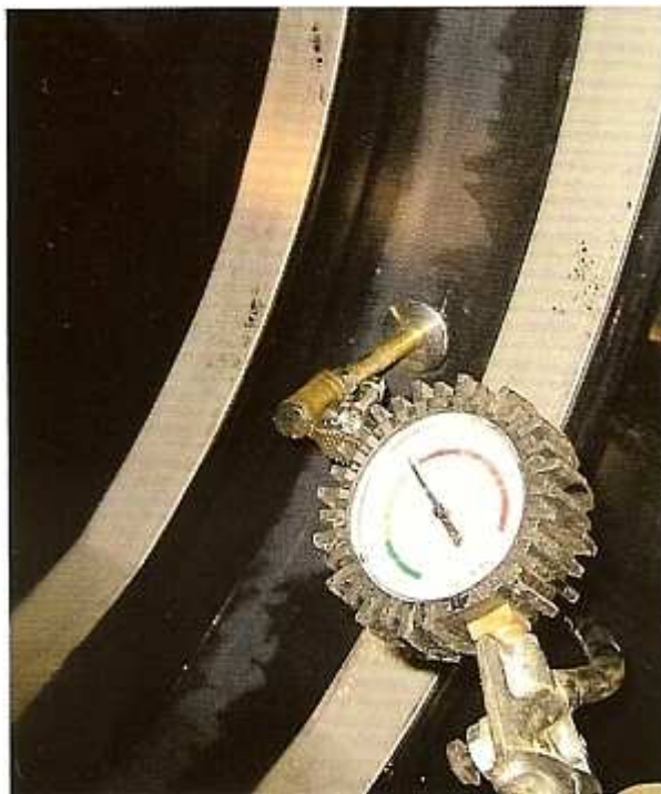
Sprawdzanie ciśnienia powietrza na pierścieniu manszety AMEX-10 MONO
